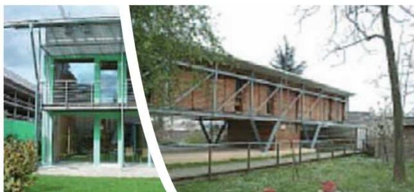
Construction sur poteaux béton
