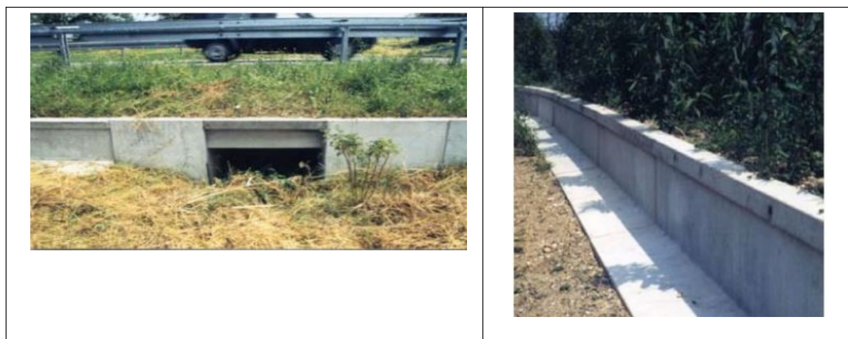
Illustrations des passages inférieurs et glissières de guidage
