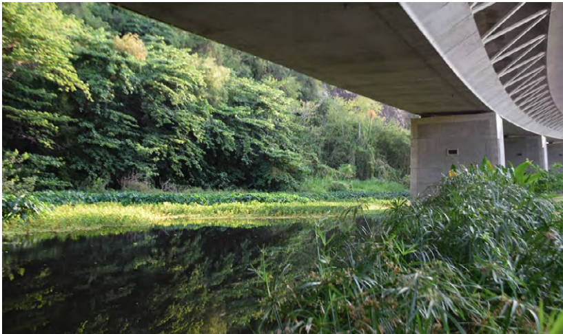
Images en cours de chantier puis quelques années plus tard
